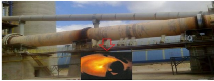
Figure I.2 : four rotatif à ciment [8]
