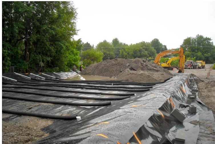
Figure 2.14. Décontamination des sols et de l'eau souterraine
