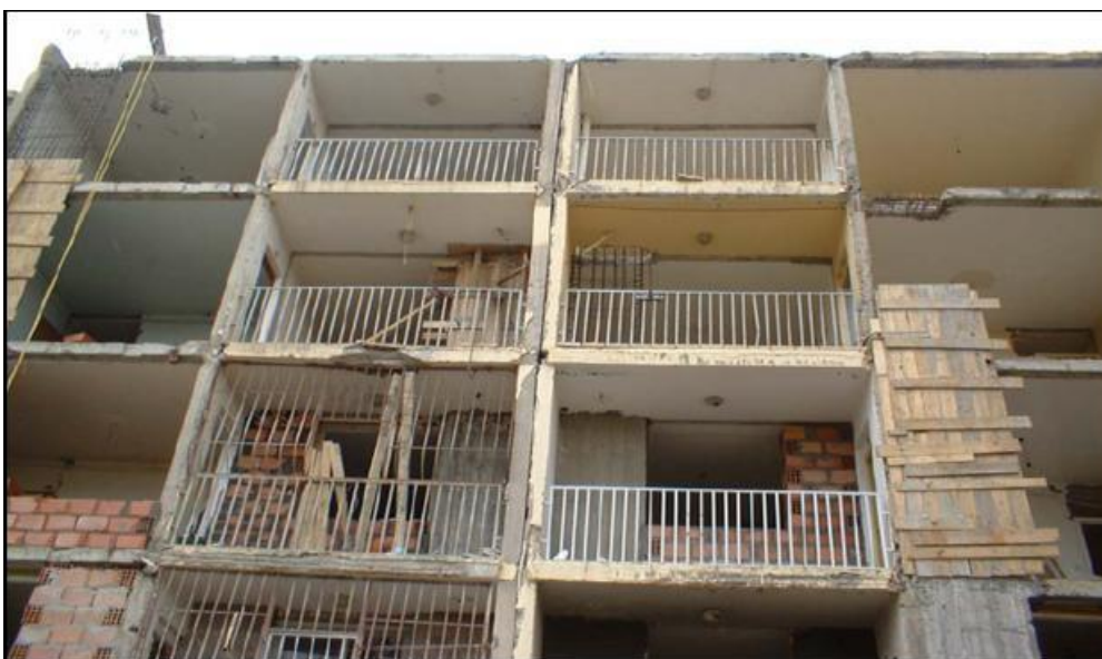
Figure 45: Renforcement avec voile
