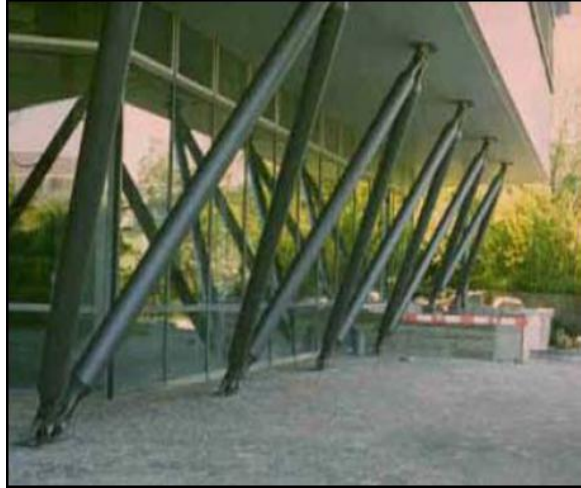
Figure 46: Renforcement par palées de stabilité triangulées
