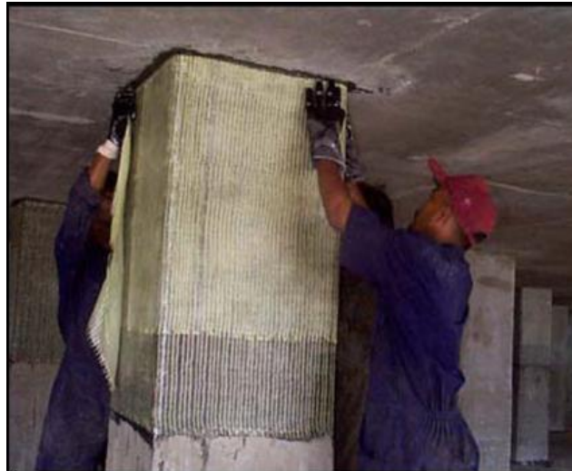
Figure 48: Renforcement d'un poteau avec des chemises en matériaux composites
