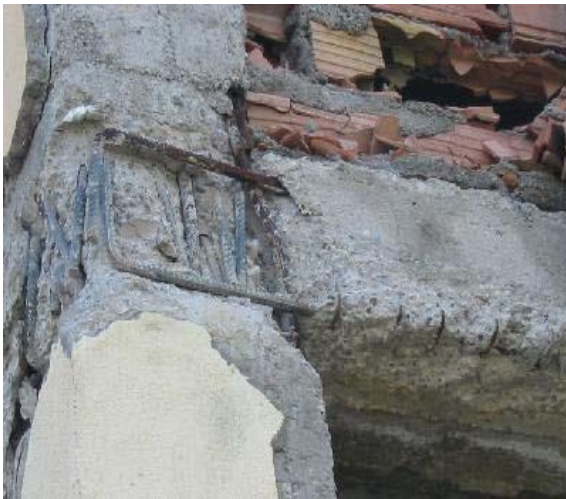
Figure 19: absence des cadre sâmi-poteau et a un biveau des nœuds(ZEMOURI)
