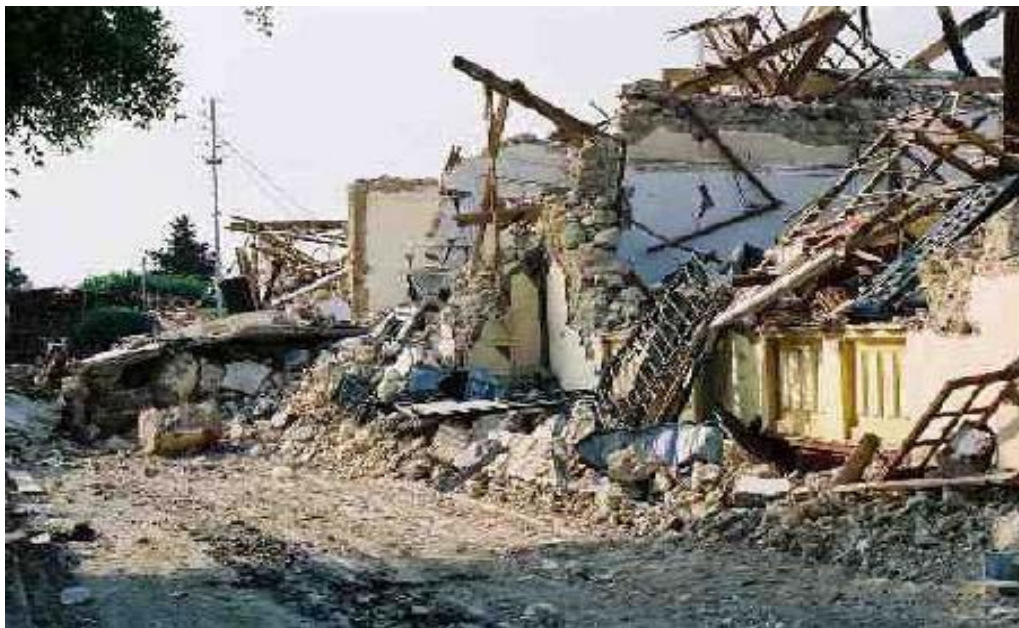
Figure 17: construction en bois murs épais (ZEMMOURI)
