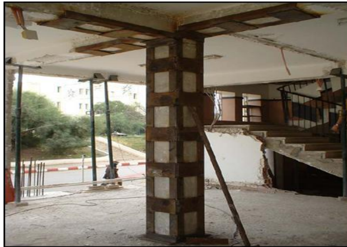
Figure 44: Chemisage métallique d'un poteau
