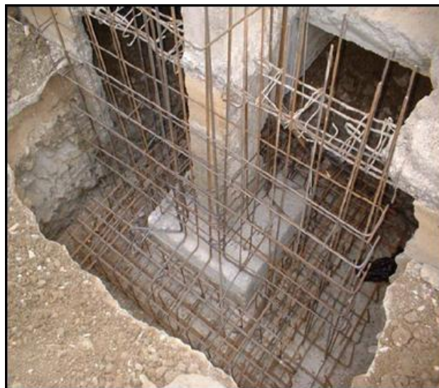
Figure 47: Renforcement d'une fondation
