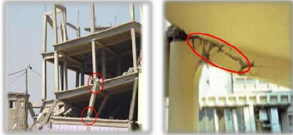
Figure II.5 : Rotule plastique au niveau des poteaux et des poutres.
