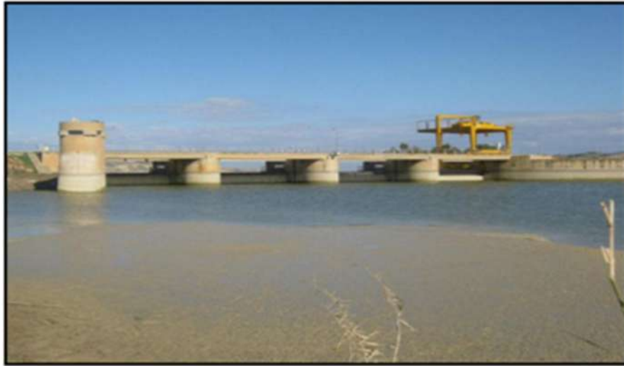
Figure I.13 : La digue et la cuvette envasée du barrage de Fergoug (2012) [19].
