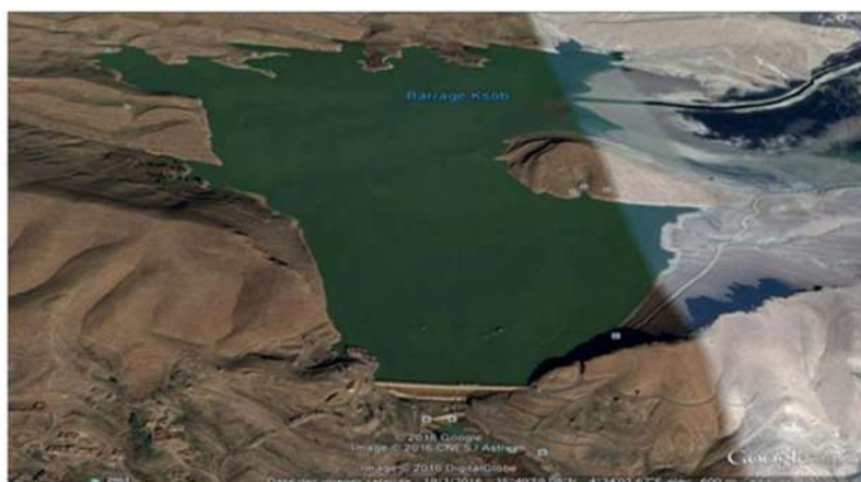
Figure 1.7 : Situation géographique du barrage de K'sob [13]
