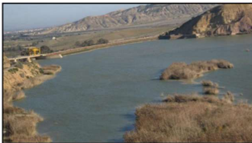
Figure I.12 : Vue du barrage de Fergoug (2012) [19].
