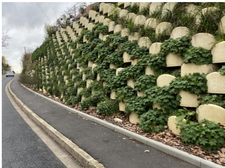
Figure I.7: Les murs de soutènement végétalisés atalus.
