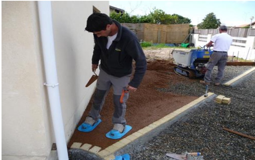
Figure I-12 : Damage du béton drainant.
