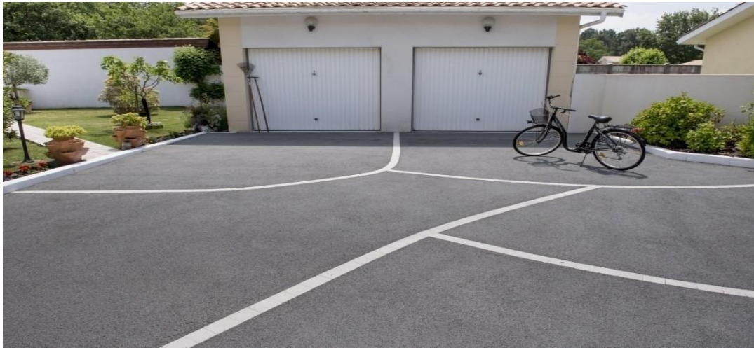
Figure I-5 : Autour d'une maison en béton drainant.
