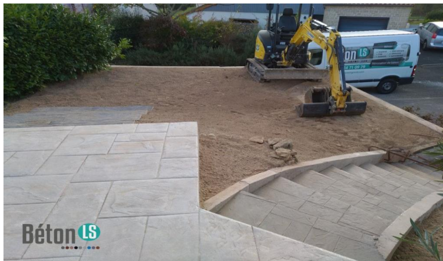
Figure I-9 : préparation du sol.
