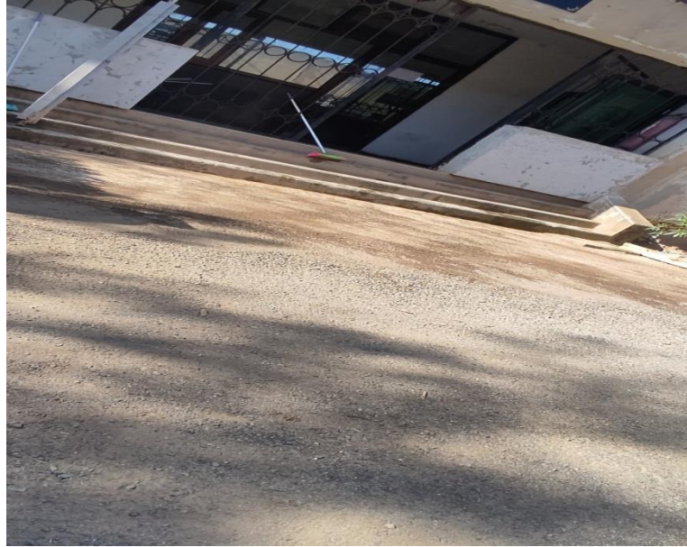
Figure IV- 20 : Préparation du terrain avant coulage des bétons.
