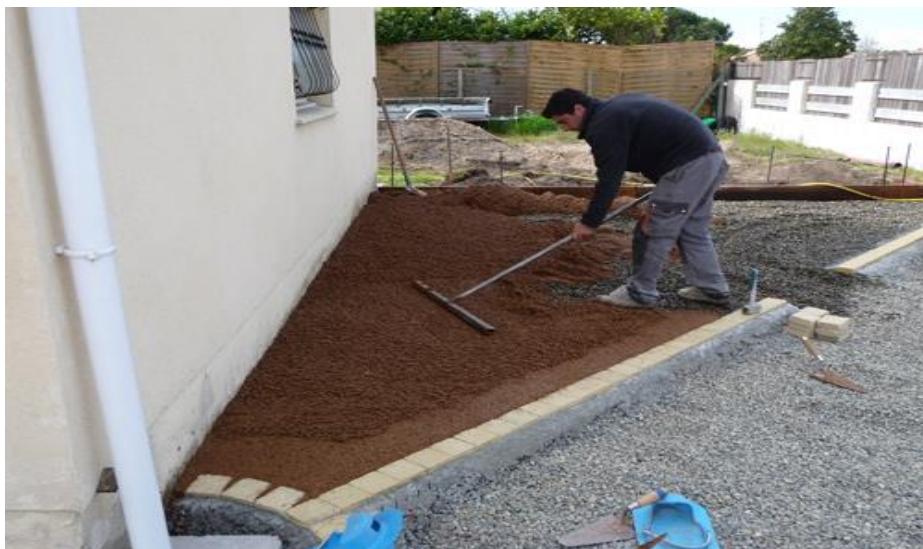
Figure I-11 : étalage du béton drainant.
