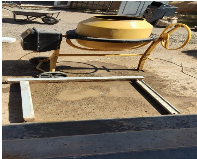
Figure IV- 23 : Mise en place des coffrages pour délimiter les surfaces.
