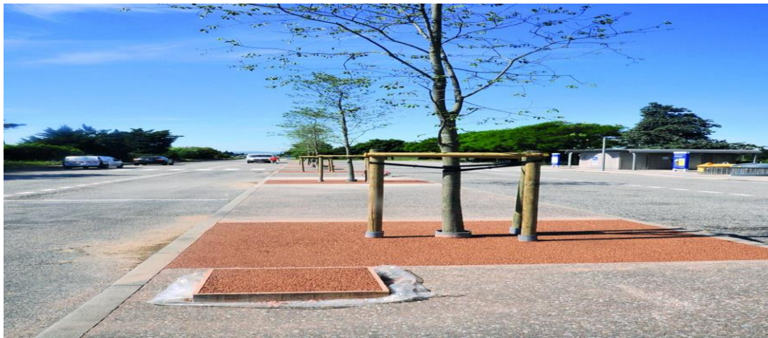
Figure 1-6 : Parking en béton drainant.
