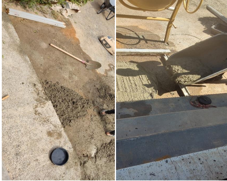
Figure IV- 24 : Coulage du béton drainant sur les côtés.
