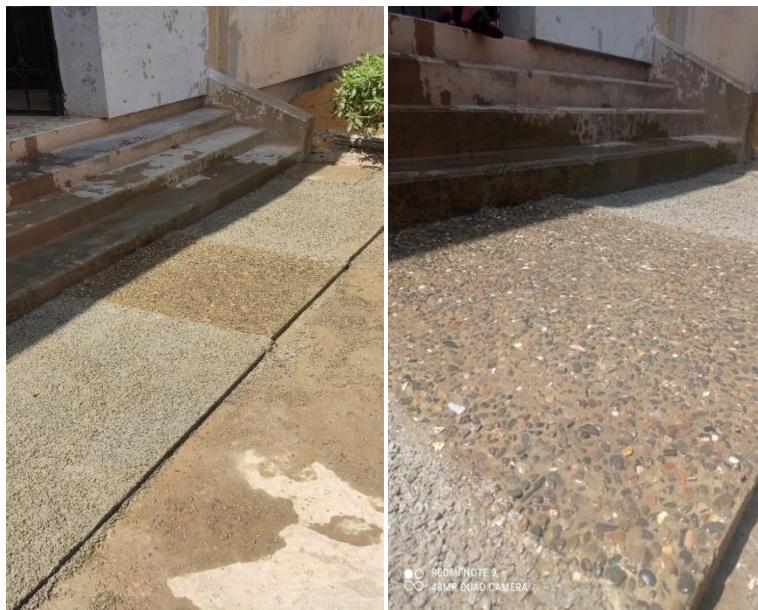
Figure IV- 27 : Aspects final des deux bétons après nettoyage de la surface supérieure du béton désactivé (au milieu).
