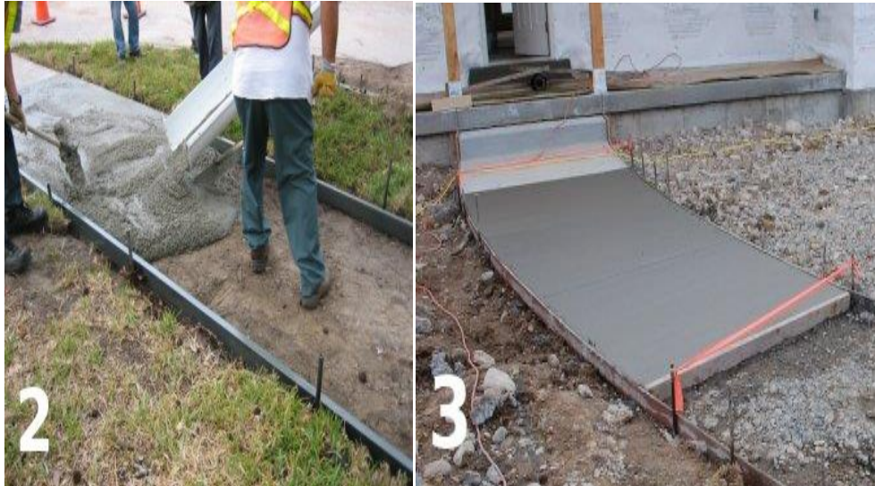
Figure II-4 : coulage du béton.
