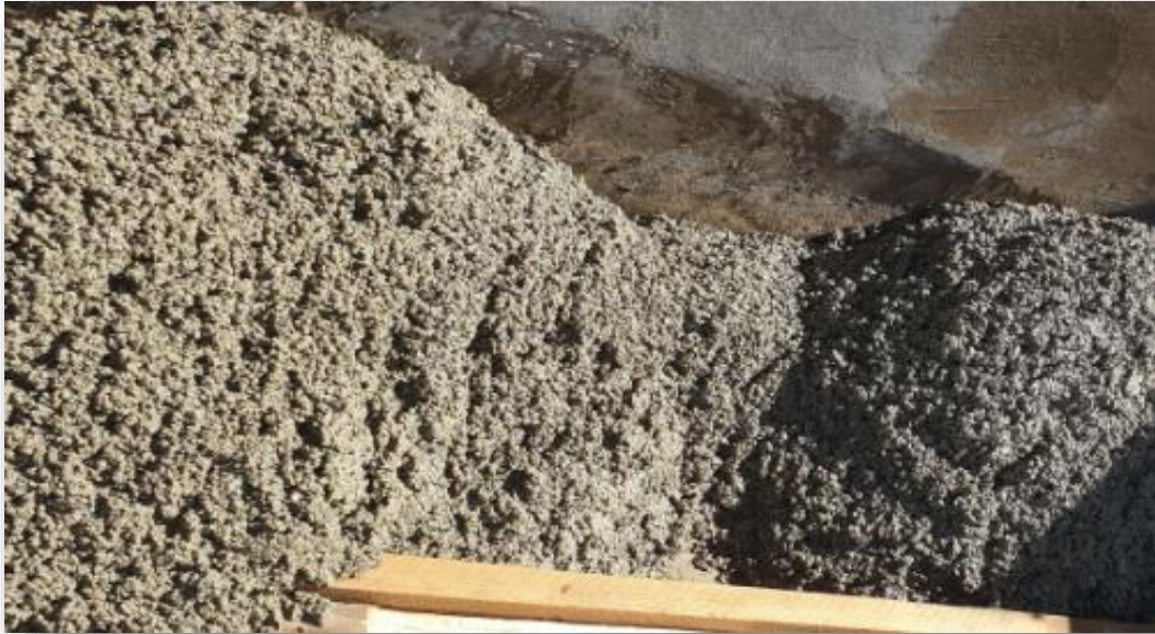
Figure III- 8 : Réalisation du béton drainant.
