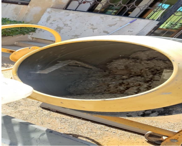
Figure IV- 22 : Malaxage et préparation des bétons selon formulations.
