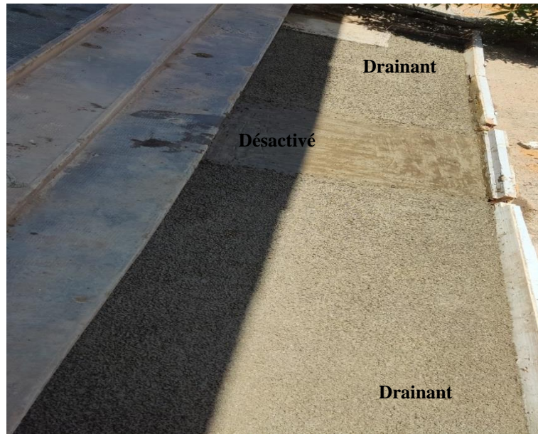
Figure IV- 26 : Aspects des bétons après coulage.
