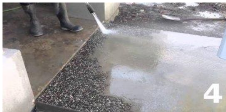
Figure II-5 : Finition, apparition des granulats.
