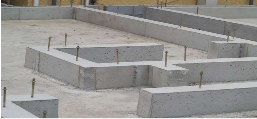
Figure VII.2 : Type des fondations superficielles
