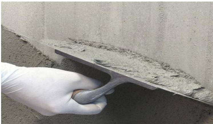
Figure 27: Ragréage de béton
