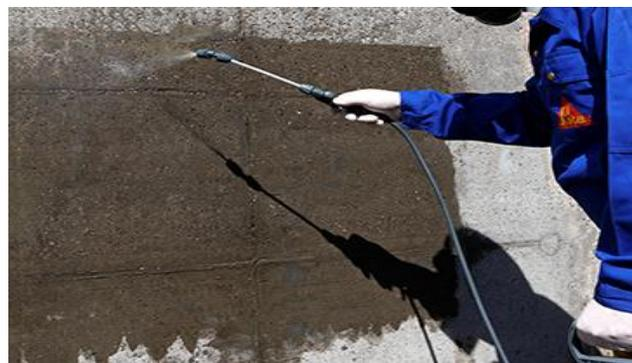
Figure 29: Inhibiteur de corrosion
