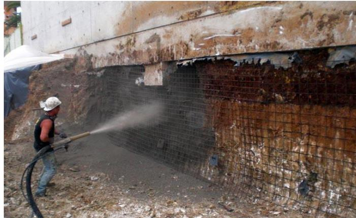
Figure 28: Béton projeté
