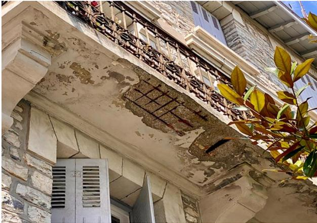
Figure 9 : La corrosion des aciers dans le béton
