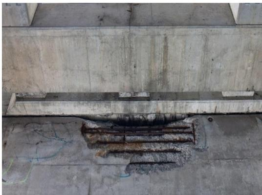
Figure 14 : dégradation due à l'action gel-dégel
