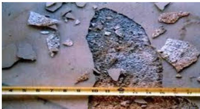
*Figure 1: Délamination de la dalle*
