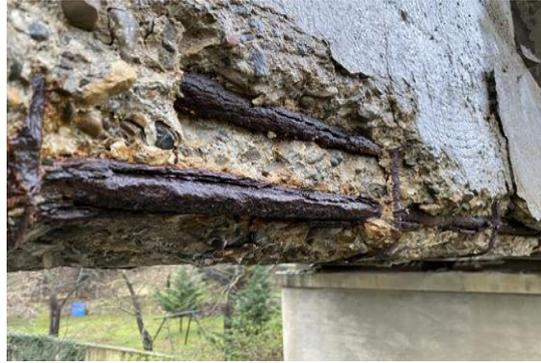
Figure 8 : Conséquences de la corrosion sur un ouvrage
