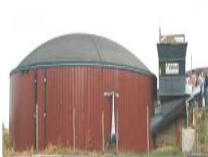
Figure II.6 : Le biodigesteur du GAEC Bets Chambre d'Agriculture du Loiret[4]
