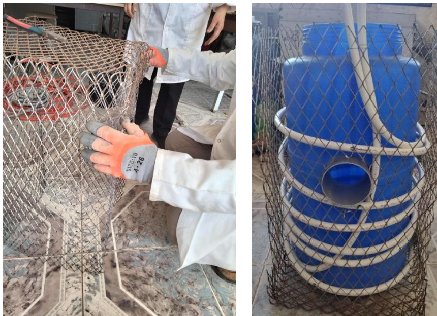
Figure III 111 a : le ferrailage
