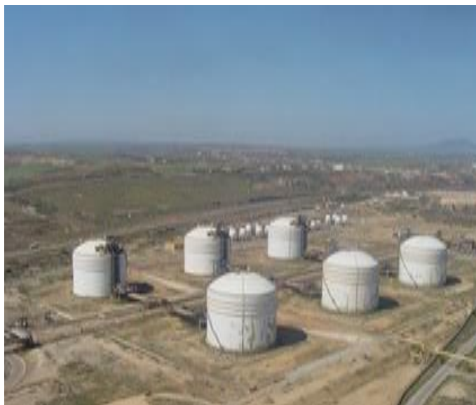
Figure I.3. Les bacs de stockage des produits finis du GPL1/Z.
