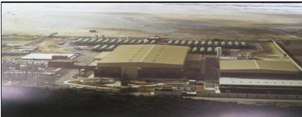
Figure n°17 : Vue générale sur la station de déssalement de Mostaganem
