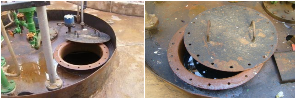
Figure II-3 Contamination du puisard de MEA par l'huile
