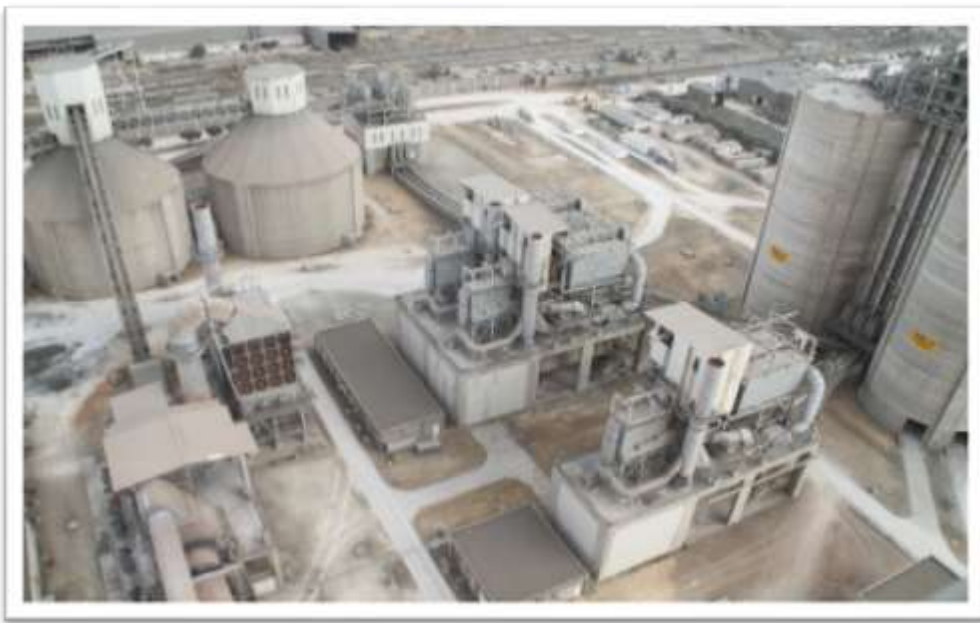
Figure I.15. Cimenterie d'OUED-SLY CHLEF
