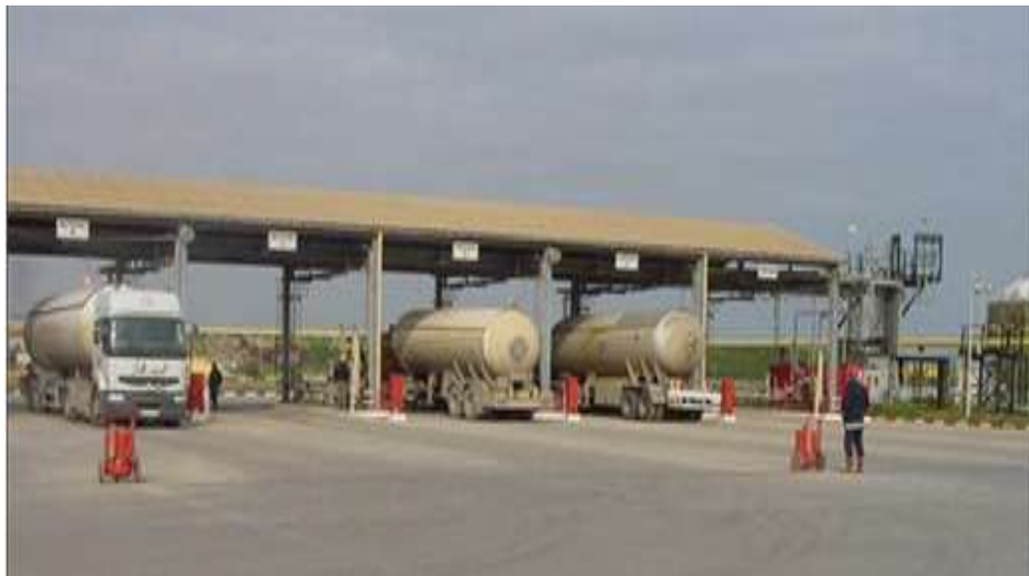
Figure 5 Lieu de chargement des camion
