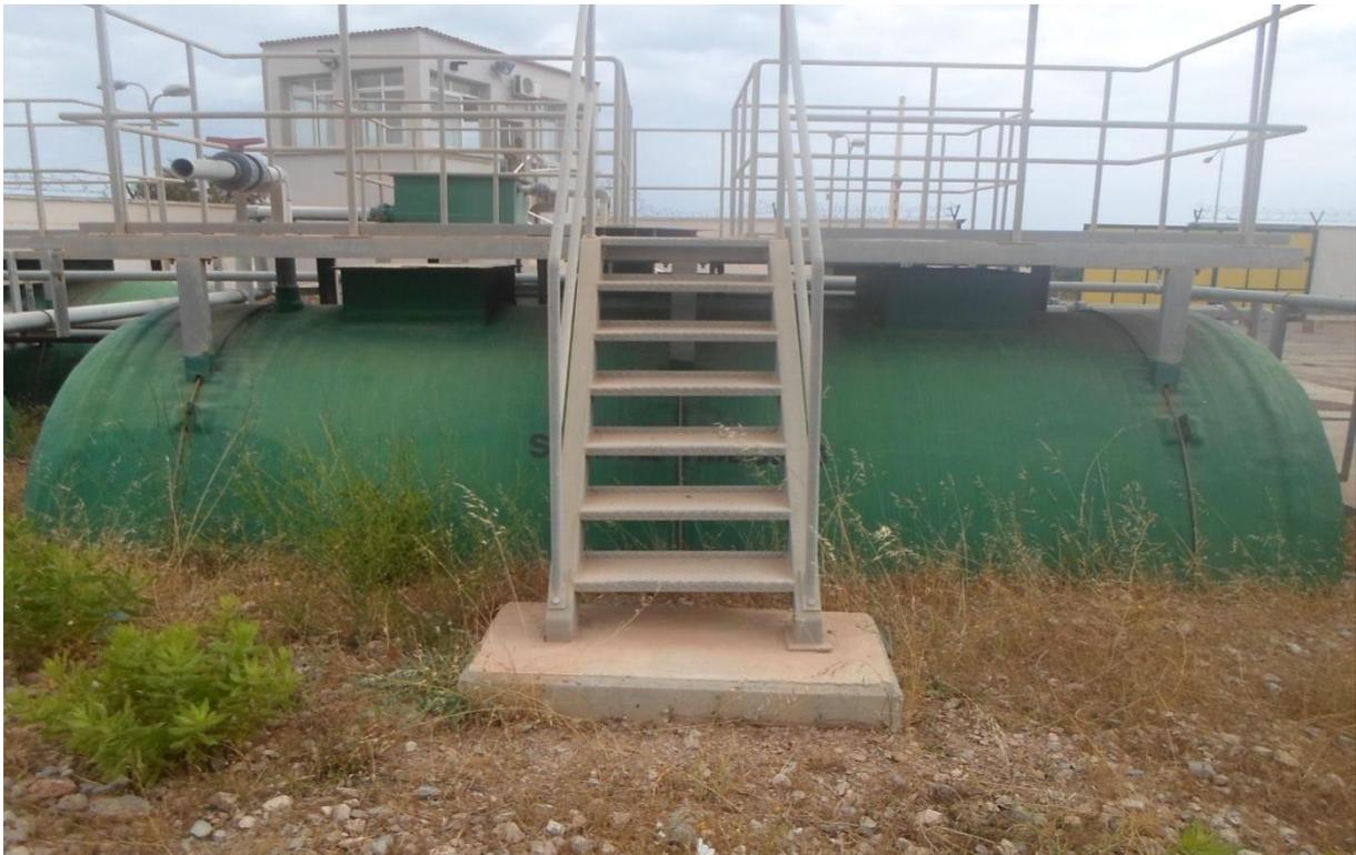
**Figure II-6** : Le ballon de maintien de la boue
