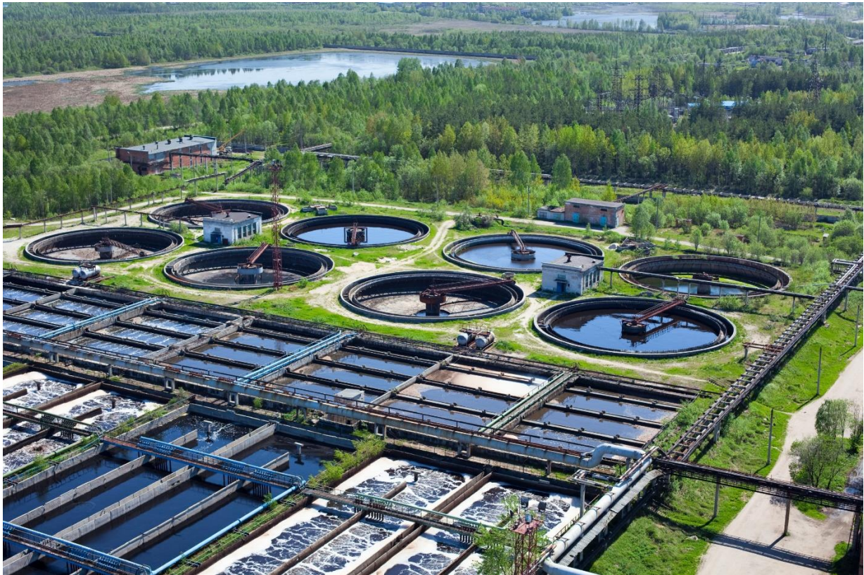
Figure I.1 : Station d'épuration des eaux usées (STEP).(Source : tlgpro)
