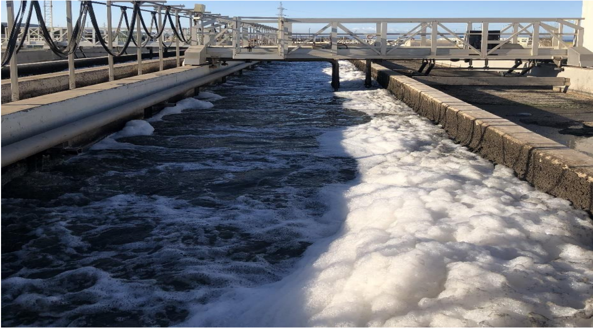
Figure I.4 : Dessablage — Déshuilage (Feknous et Cheikh.2022)
