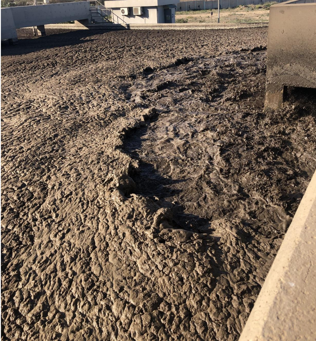
Figure I.6 : Bassin biologique (Bassin d'aération) (Feknous et Cheikh.2022)
