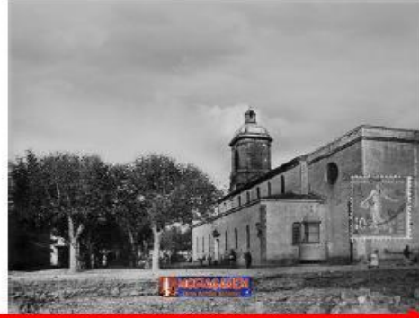
Eglise saint jean baptiste après la démolition de la caserne du Barail Source Delacampe.net
