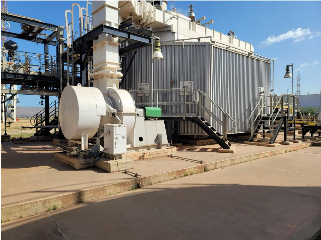
*Figure 18 : Chaudière à tube d'eau du complexe GPI/Z.*
