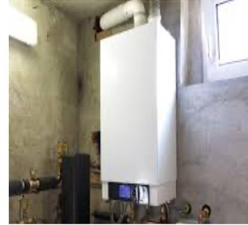
*Figure 14 : Chaudière à condensation au gaz.*
