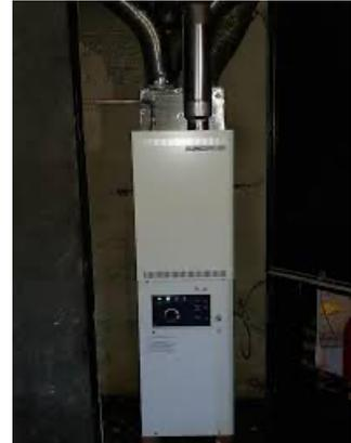
*Figure 16 : Chaudière à air pulsé.*
