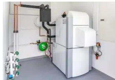
*Figure 13 : Chaudière à condensation au fioul.*
