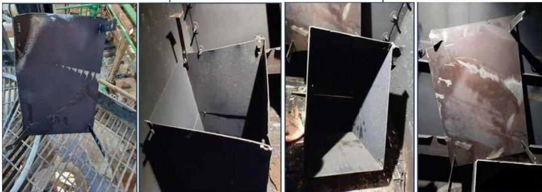
Les deux déflecteurs situés dans le fond inférieur de l'équipement, sont complètement détachés et présentent des endroits d'arrachements de métal au niveau des soudures de liaisons des fers plats de fixation.
