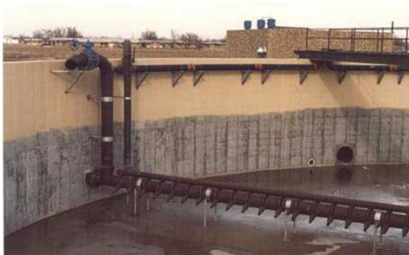
**Figure II.2 :** Vue de dessus SBR avec système d'aération et de recirculation des boues mixte.
