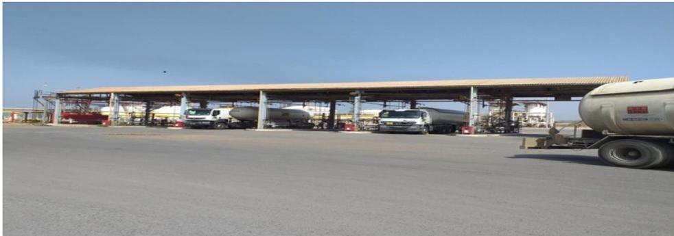
**Figure II.9:** Rampe de chargement de camions du GPL1/Z[12]
