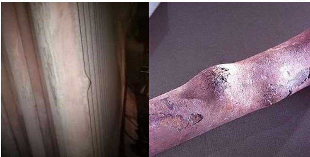
Figure III.4 : un gonflement au niveau les tubes de surchauffeur [18]
