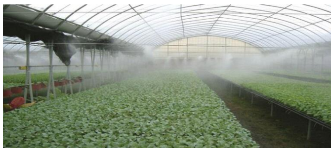
Figure V.6 : Refroidissement par brumisateurs
