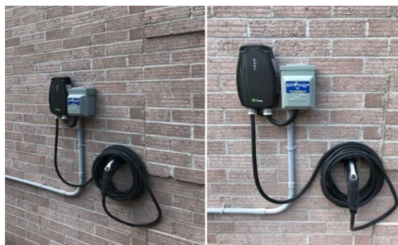
Figure 09 : Borne de recharge niveau 2
