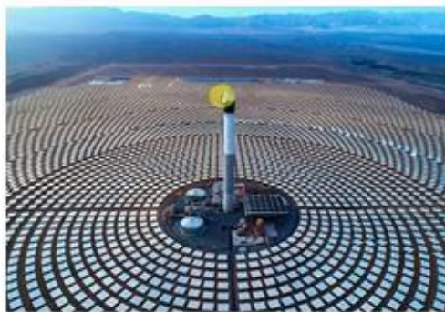
Centrales à tour
