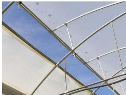
Figure 30 : Exemple de système d'aération naturelle constitué de fenêtres rabattables ou basculantes
