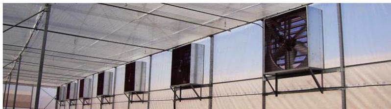
Figure 31 : Exemple de système d'aération forcée constitué de ventilateurs/extracteurs
