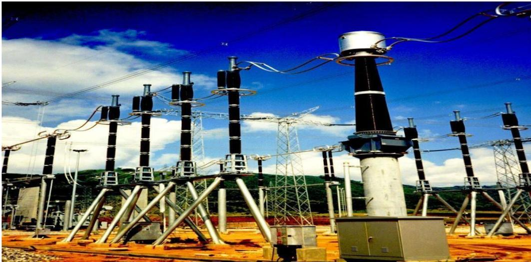
Figure I.10: Un disjoncteur à haute tension [6].
