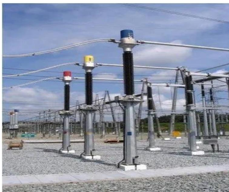
Figure I.12: Transformateur de mesure [6].
