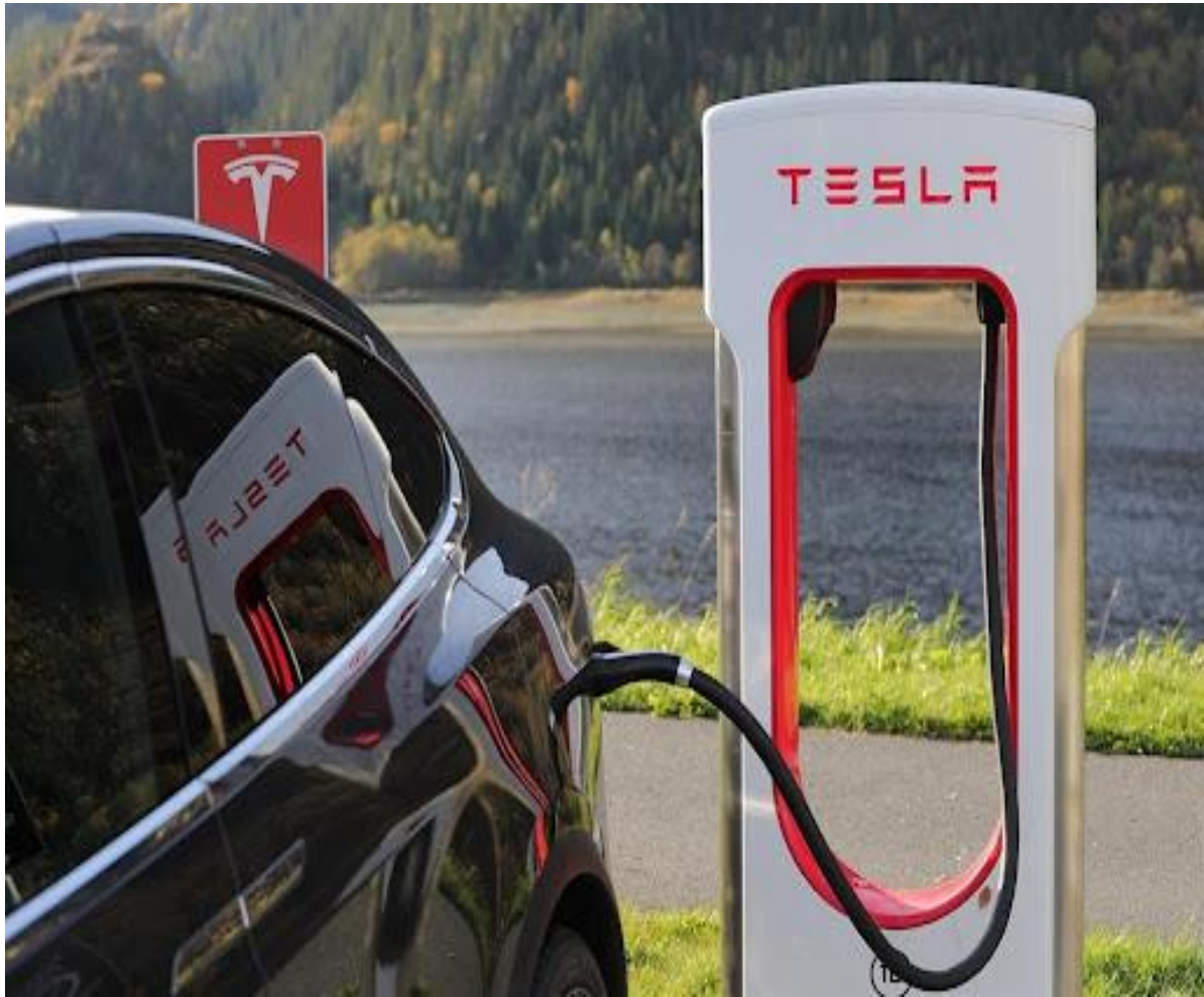
الشكل 13: استبدال موزعات الوقود الحراري بموزعات الشحن الكهربائي. 1
