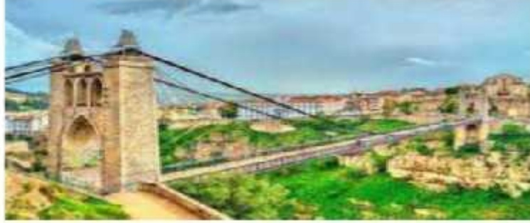
صورة 3/ جسر سيدي مسيد 1
