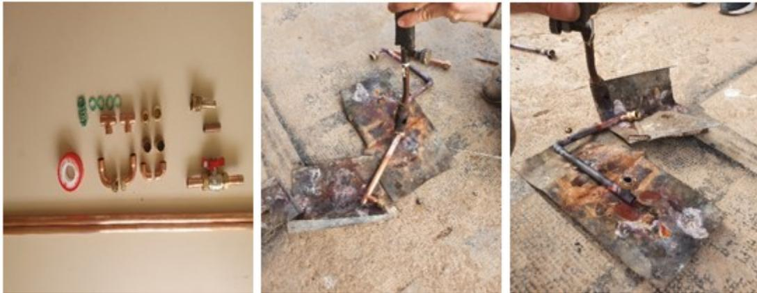
Figure 3.3 Soudage des tubes en cuivre.
