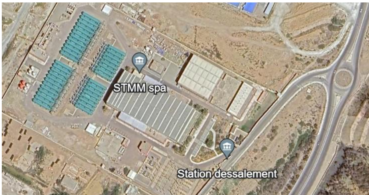
Figure III-6 : station dessalement de Mostaganem
