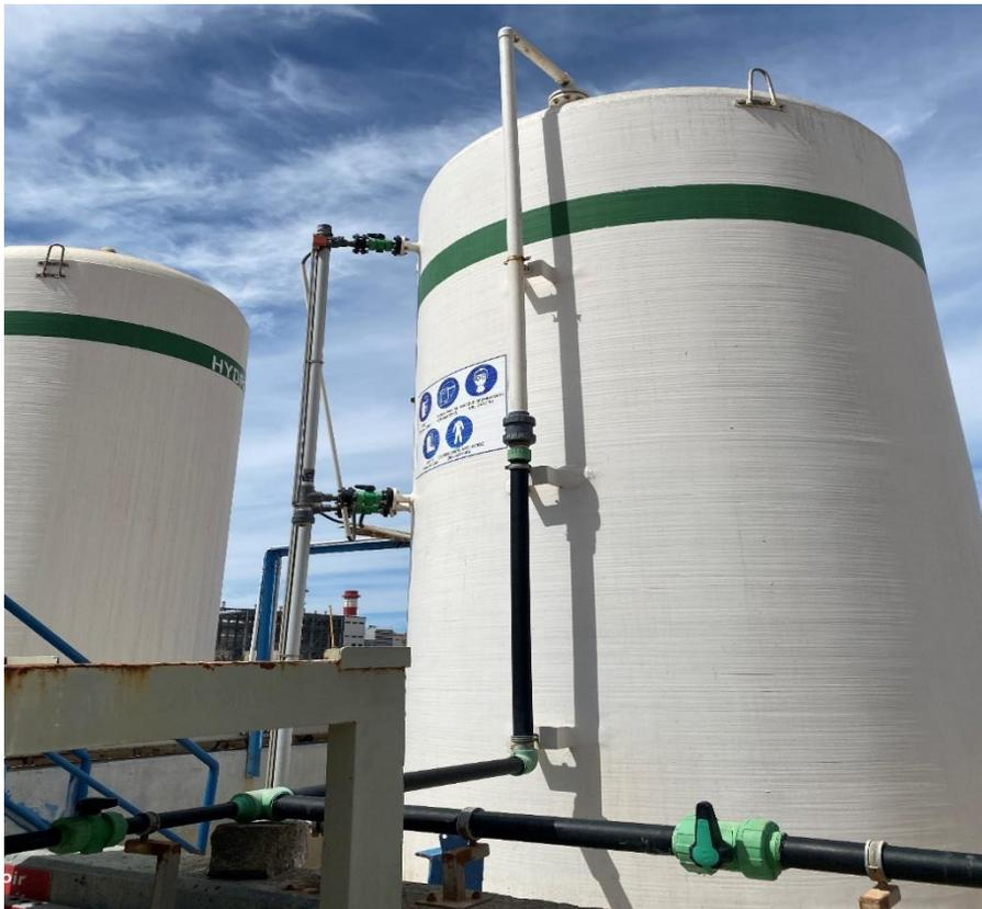
**Figure 19. Silos de NaClO (Photo de silos de hypochlorite de sodum, Bahraoui, 10 /05/2024)**
