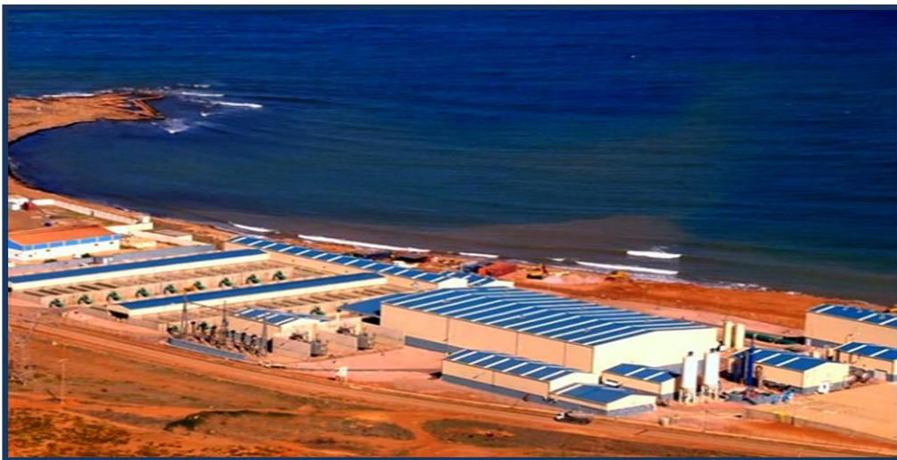
Figure 9. Vue générale sur Station de dessalement de l'eau de mer Unité de TENES (AEC - Algerian Energy Company www.aec.dz )
