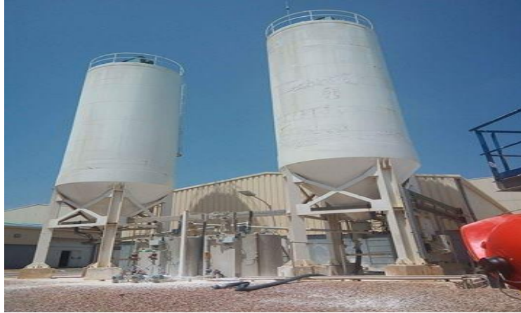
Figure 21. Silos de stockage de \text{CaCO}_3 [Photo prise au niveau de la station de dessalement de Ténès 2023].
