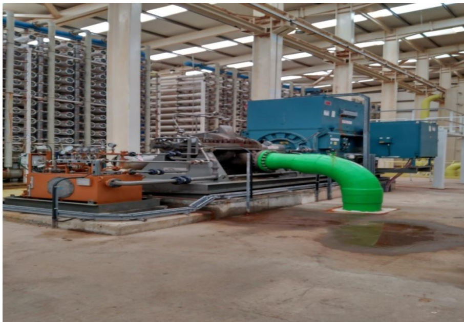
Figure 14. Bâtiment d'osmose inverse [Photo prise au niveau de la station de dessalement de Ténès 2023]
