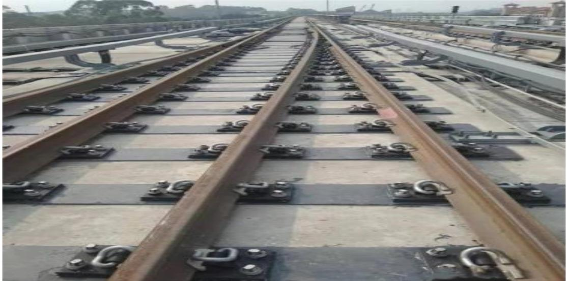
Figure 27 : Traverses en composite de fibre de verre de chemin de fer
