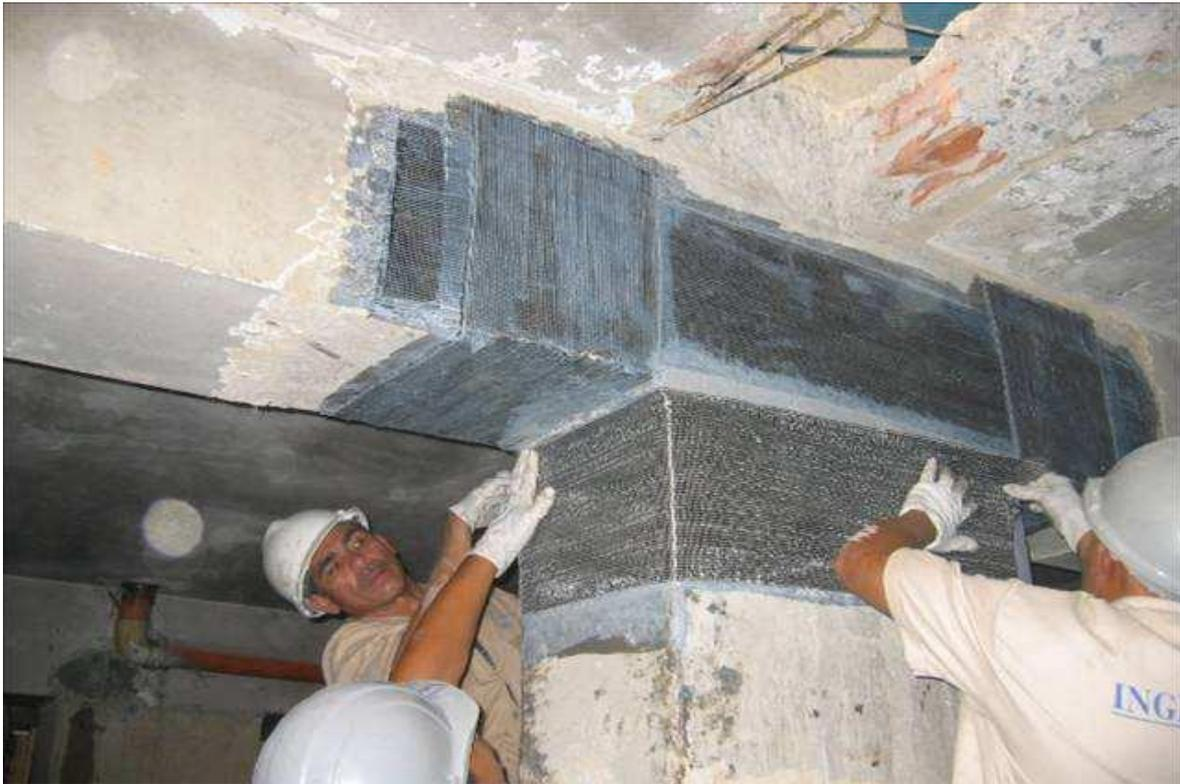
Figure 26 : Renforcement de l'intersection poteau poutre avec les fibres de carbone
