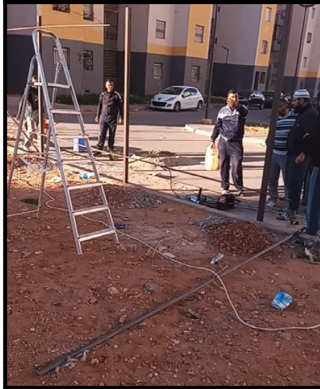
الصورة 24 توضح تواجدنا اثناء عملية التسييج بحي 1100 مسكن
