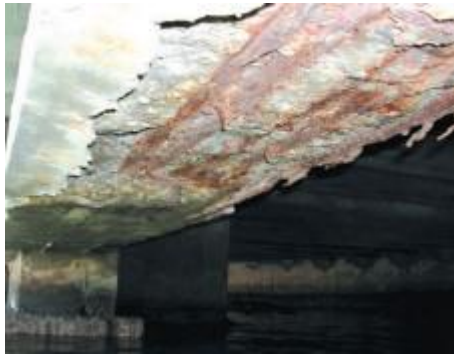
Figure 18 : corrosion des armatures
