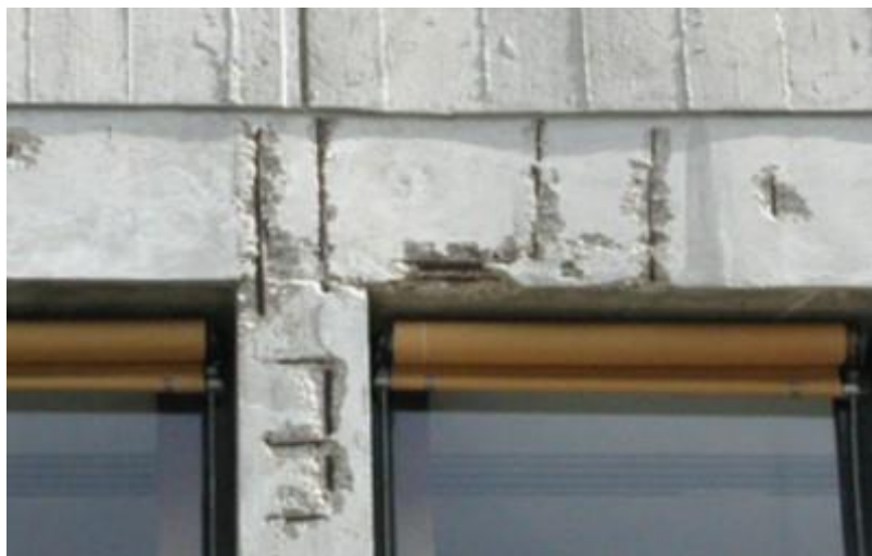
Figure 15 : pathologie de la carbonatation
