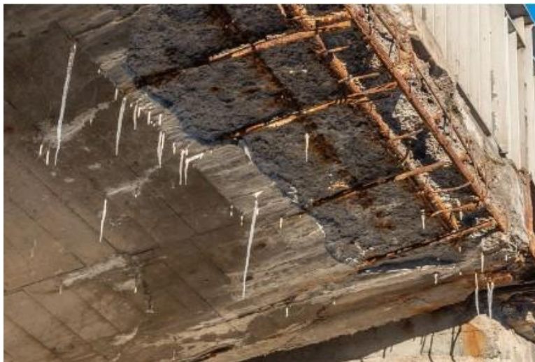
Figure 17 : Cycle gel-dégel
