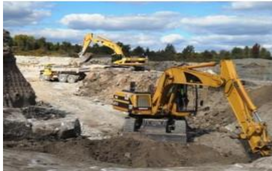
Figure 11: Décapage des terrains
