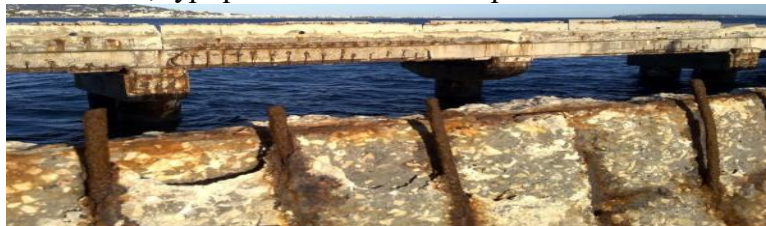
Figure 20 : attaque des ions chlorures
