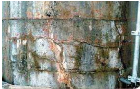
Figure 16 : réaction interne sulfatique
