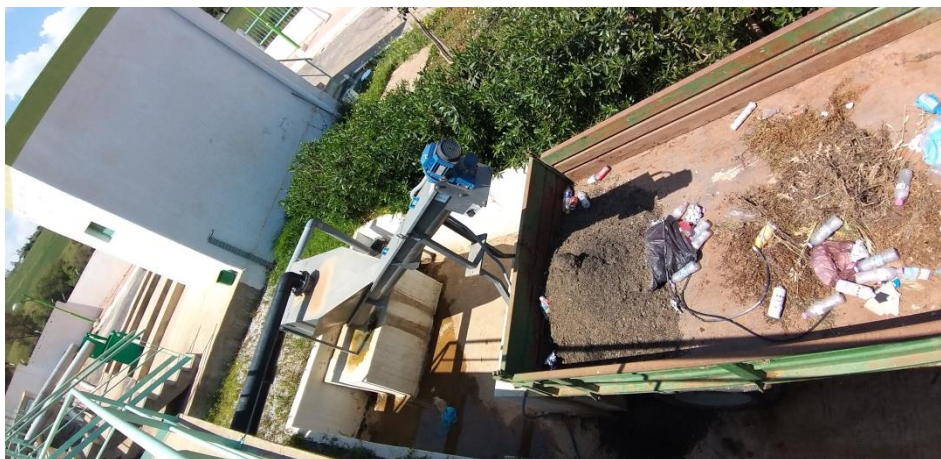
Photo. V.12. Classificateur à sable (STEP Sidi Ali, 2024)
