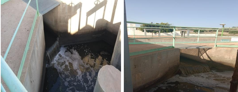
Photo. V.4. Ouvrages d'entrée (STEP Sidi Ali, 2024)
