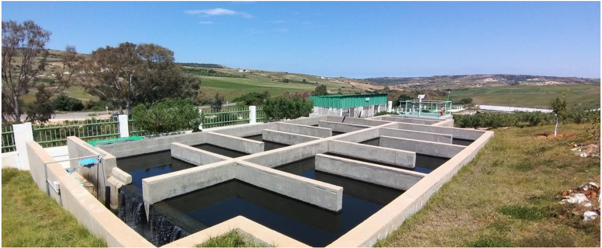
Photo. V.24. Bassin de désinfection (STEP Sidi Ali, 2024)
