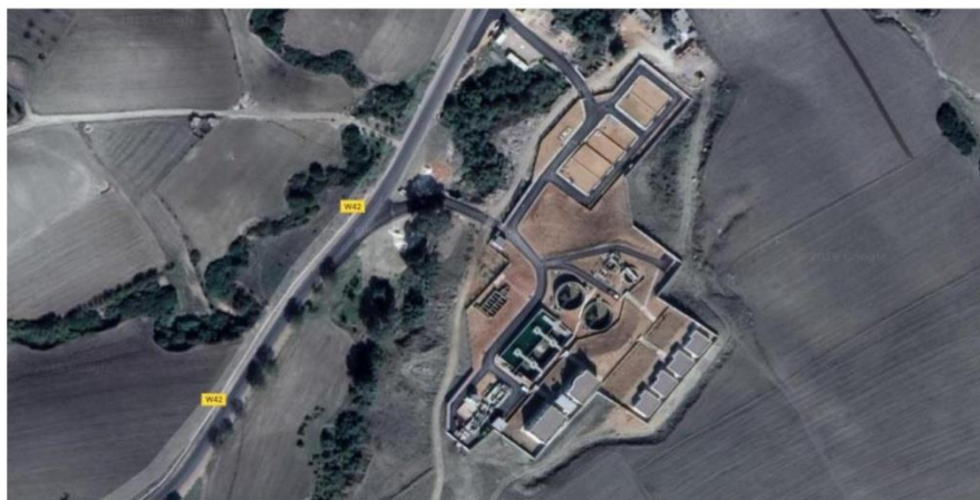
Fig.V.3: vue de la station d'épuration de Sidi Ali (google earth, 2024)
