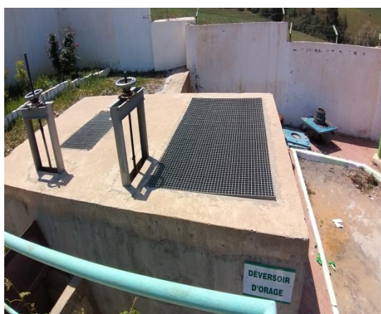
Photo.V.1. Le déversoir d'orage (STEP Sidi Ali, 2024)
