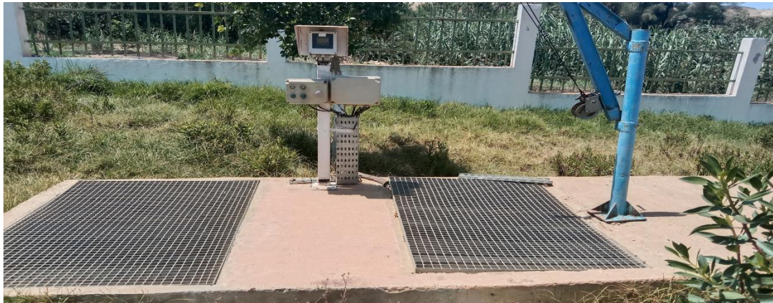
Photo. V.23. Regard d'accumulation de toutes les eaux (STEP Sidi Ali, 2024)
