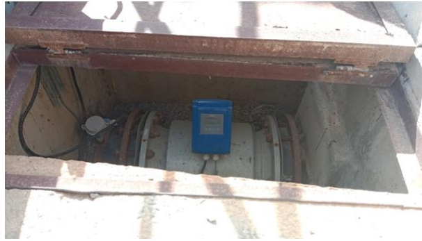
Photo.V.2. Débitmètre d'entrée (STEP Sidi Ali, 2024)
