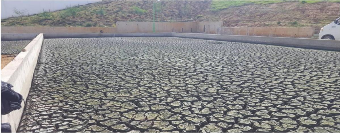
Photo. V.22. Lits de séchage (boues séchées) (STEP Sidi Ali, 2024)
