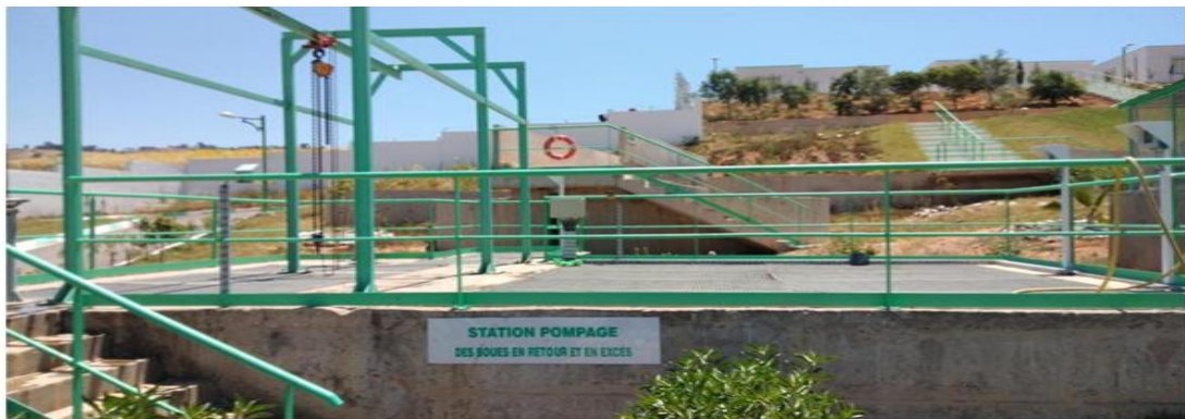
Photo. V.19. Station de pompage des boues (STEP Sidi Ali, 2024)
