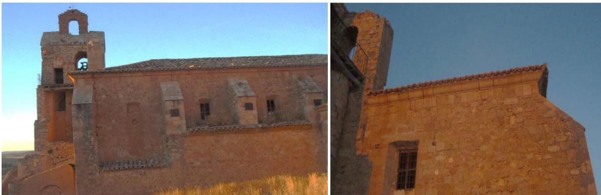
**Figure B.2** État des façades Sud (Inclinaison : mur Ouest. Manque d'attache : toit. Plaque des bretelles. Fissures verticales) et Ouest; Eglise de nuestra señora de la asunción de Monreal de Ariza, Saragosse. (Monjo-Carrió et al., 2018)
