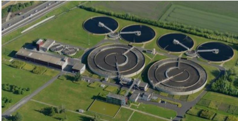
Figure I-1 : Vue aérienne d'une station d'épuration [4]
