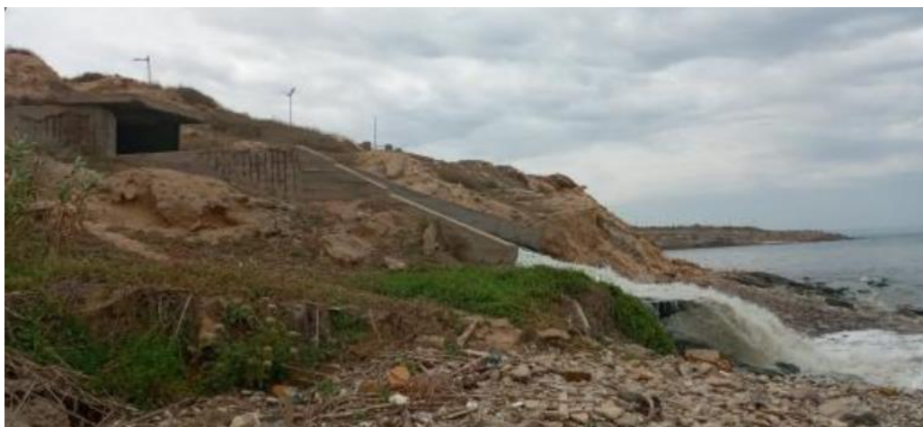
Figure I-5 : Rejet de l'eau dépolluée en mer
