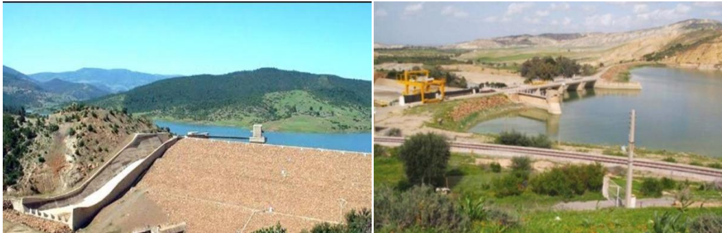
Fig. 06 : Le barrage de wilaya de Mascara.
