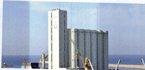
**Silo à céréales** : Mis en service en 1986 sur le môle de l'indépendance, doté de 12 cellules et 02 portiques à grain d'un débit horaire de 300 tonnes chacun, d'une capacité de stockage de 30 000 tonnes ;
