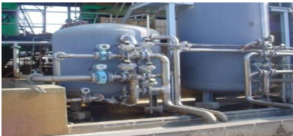
Figure 12 : Filtre à sable et anthracite (ZIANE B, BENFATMA A., 2023)
