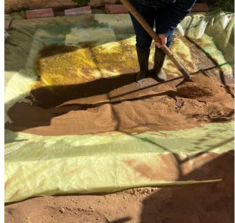
Figure 19 : Ajout une couche de sable (photo originale 2024)
