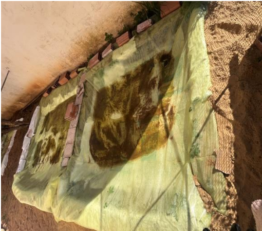
Figure 18 : la mise en place de bâches dans chaque bassin (photo originale 2024)
