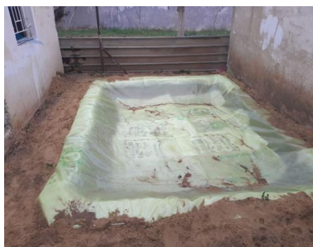
Figure 20 : Mise en place des bâches étanches (photo originale 2024)
