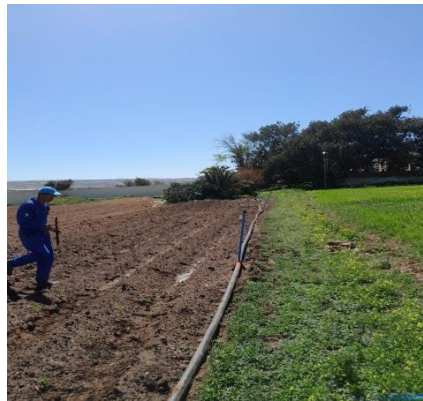
Figure 32 : Installation du système d'irrigation (photo originale)
