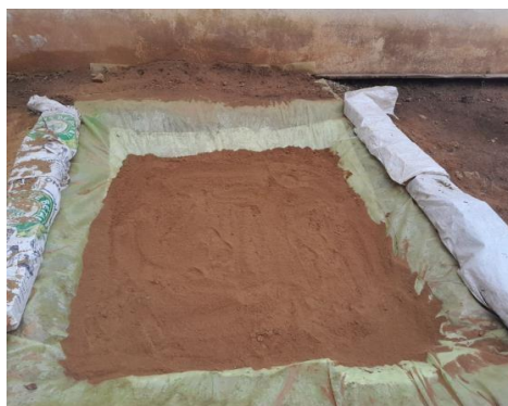
Figure 21 : Ajout d'une couche de sable à l'intérieur des bassins (photo originale 2024)
