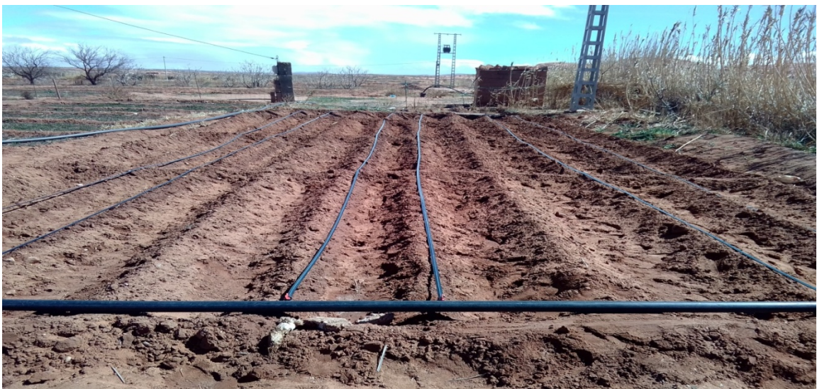
Figure N°41: Installation de système goutte à goutte (Original)
