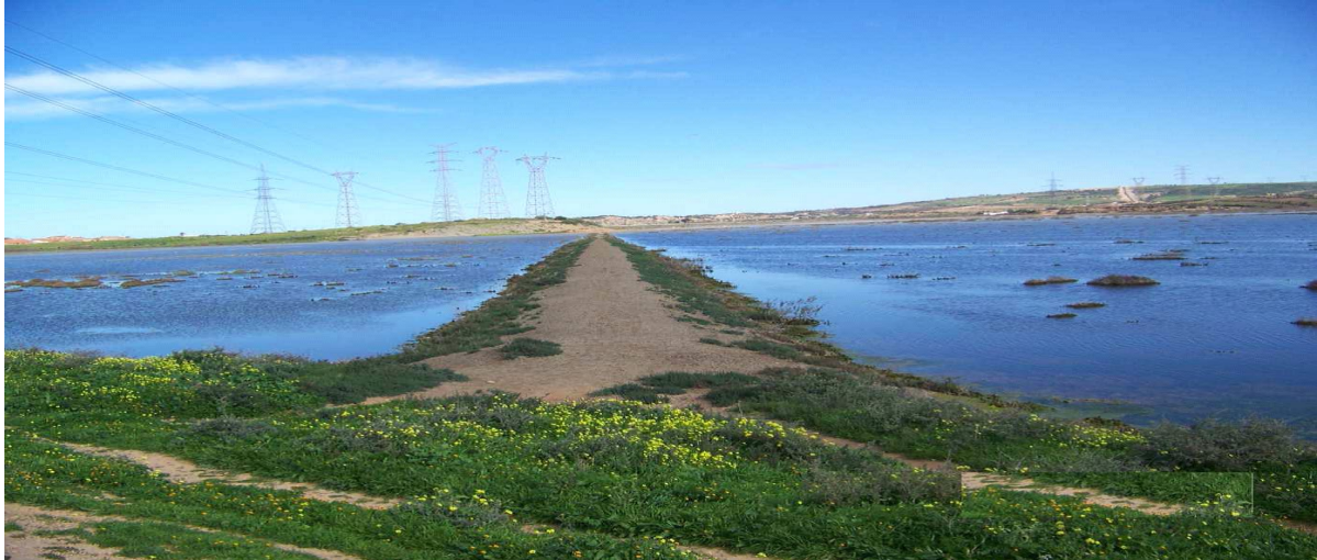
Figure n° 22 : Le passage du gazoduc dans le marais de la Macta.
