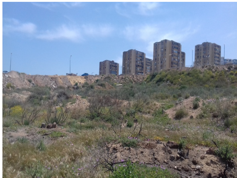
Photos N° 12: Site Kharrouba (Banouh.K 2018).
