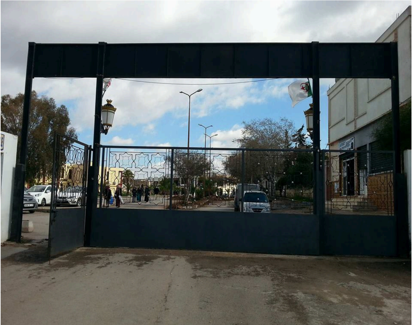
Figure III.8 : portail coulissant manuellement
