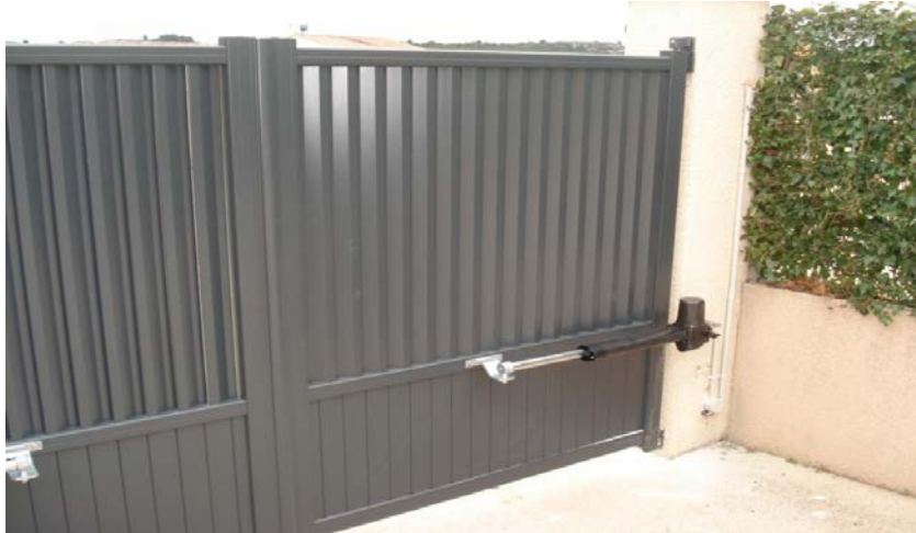
Figure. I.4 : Portail automatique à vérins
