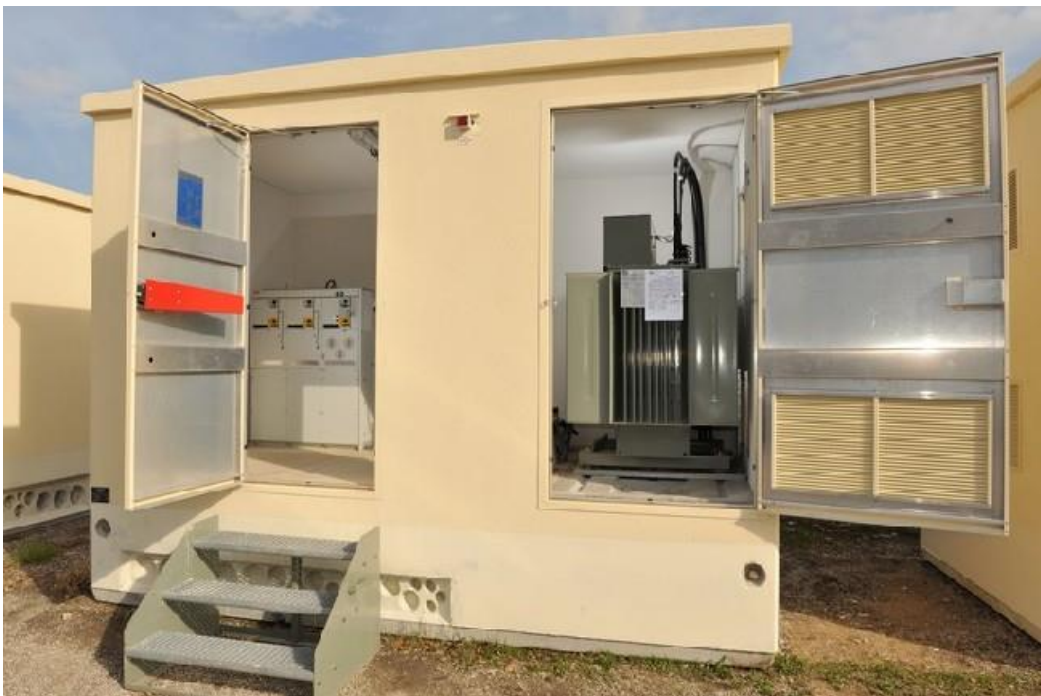
Fig 1-6 a. Poste transformateur préfabriqué
